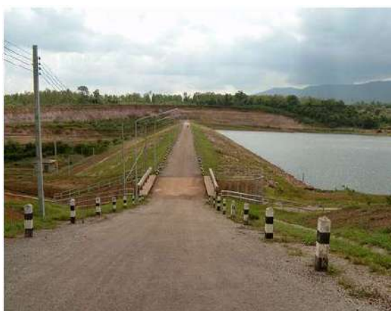
รูปภาพที่ ๓๐ ตัวอย่างอ่างเก็บน้ำ ที่มา: สำนักงานการปฏิรูปที่ดินเพื่อเกษตรกรรม.(๒๕๖๑).
