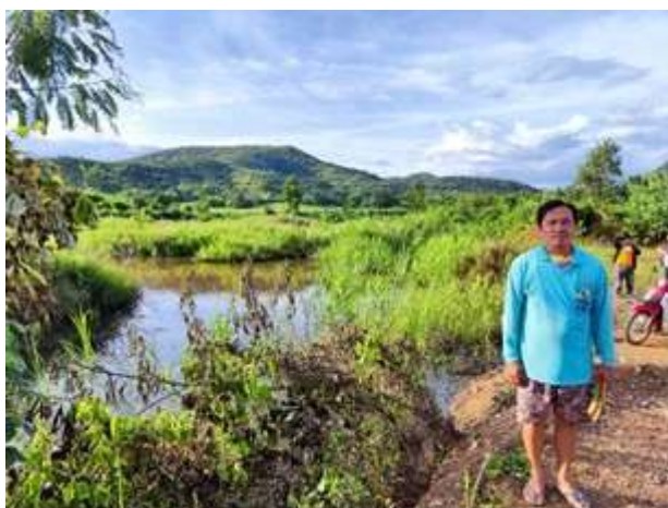
รูปภาพที่ ๙๖ โครงการขุดลอกสระเก็บน้ำสาธารณะ บ้านวังกกจาน หมู่ที่ ๓ (SPBW๖๕-๐๑๐)
